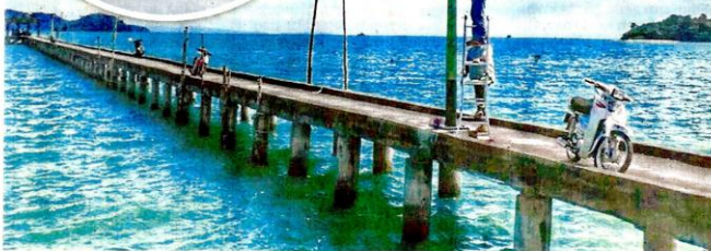
MYLIPOS untuk kegunaan lampu jalan bersama solar fotovoltaik (PV) yang dipasang di salah sebuah jeti.
